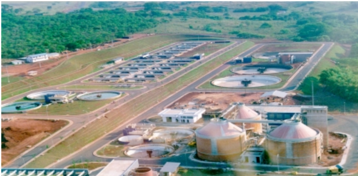
Figura 1: Vista aérea da ETE de Franca.
